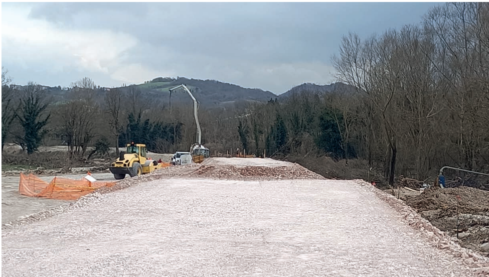
Qui e sopra, lavori in corso per il ripristino della linea ferroviaria Fabriano-Pergola dopo l'alluvione
